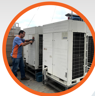
Instalação de Ar Condicionado
